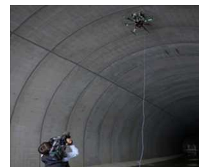
トンネル(PC覆工)
