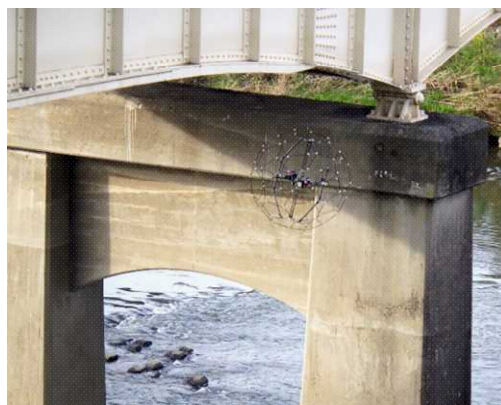
実橋梁での点検試行
