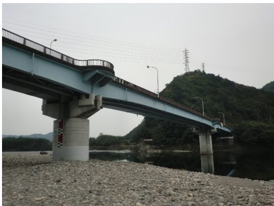
写真-1 フィールド対象橋梁（桁下）
