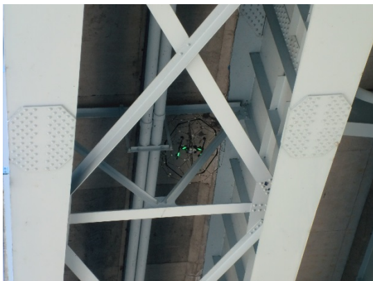
写真-3 狭隘空間で稼動する飛行ロボット
