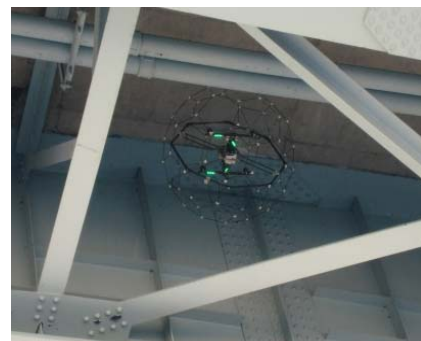
写真-1 飛行ロボット稼動状況
