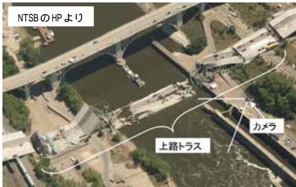
写真-2 崩壊状況 (11)
