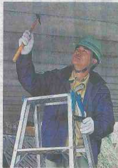
老朽化した橋の状態を調べる社会基盤メンテナンスエキスパートの林忍さん＝岐阜市栗野西
