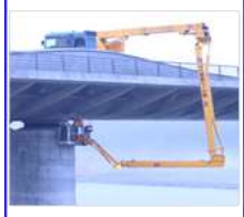
近接目視点検による確認
