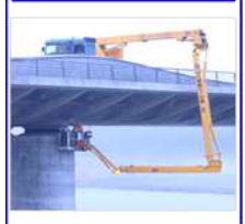
近接目視点検 による確認
