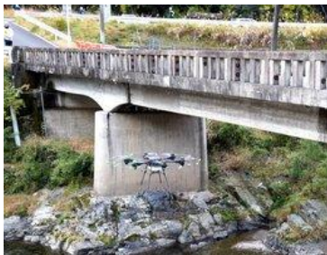
富川橋の損傷箇所などを点検するドローン（大津市大石富川1丁目）
