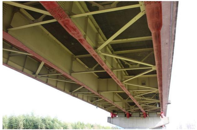
図-12 鋼鈹桁橋（岐阜市内K橋）
