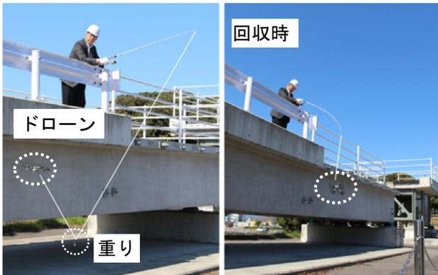
図-21 ドローン落下時の回収対策
