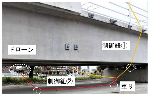
図-20 飛行範囲の制約対策
