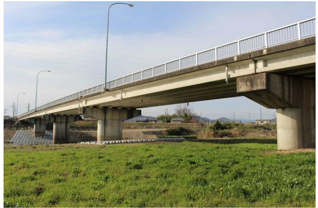
図-17 プレビーム桁橋（岐阜市内F橋）
