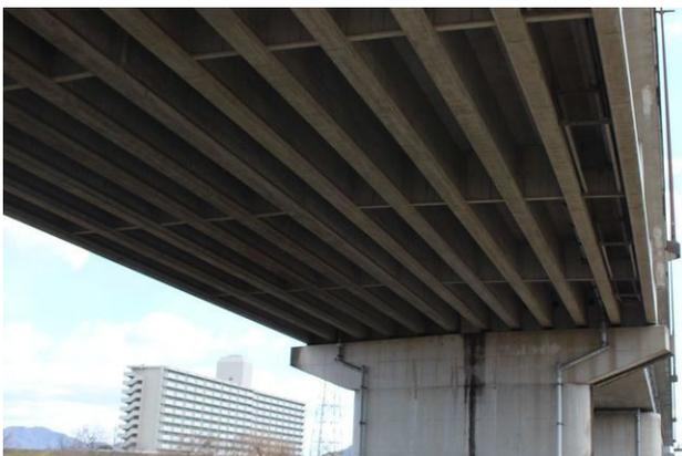
図-7 ポステンPCT桁橋 (岐阜市内S橋)
